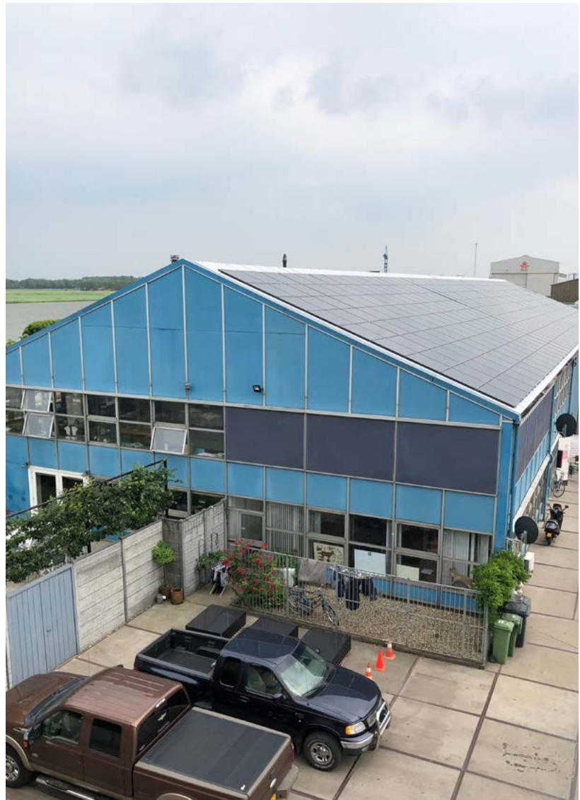
Op de bedrijfshallen liggen in totaal 756 zonnepanelen, goed voor een energiebesparing van 20 tot 25 procent.
