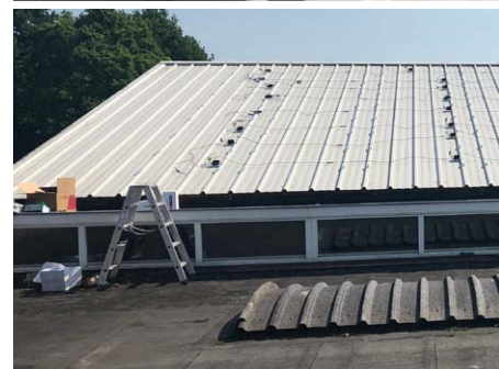
Een profiel van het eenvoudig te monteren ClickFit EVO staal-daksysteem (foto boven). De foto onder toont de op maat gemaakte rails van het systeem waarop de installateur de zonnepanelen klikt en vastmaakt.
