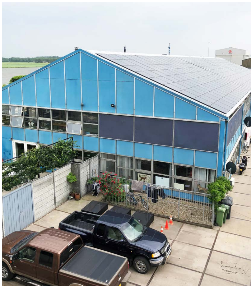
Auf den Betriebshallen liegen insgesamt 756 Solarmodule, was einer Energieeinsparung von 20 bis 25 Prozent entspricht.
