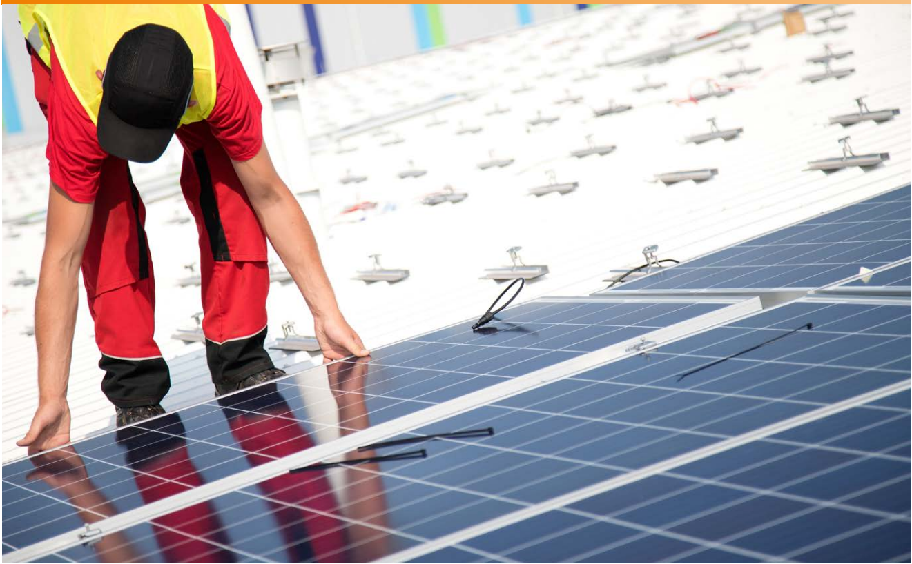
NoCo2-Installateure klicken die Solarmodule einfach in die Profile des ClickFit EVO-Systems ein.
