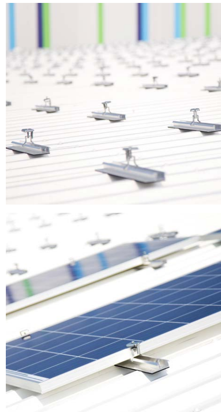
Profile des ClickFit EVO-Montagesystems auf dem Stahldach in Hoogezaand. Hier werden letztendlich 3.150 Solarmodule liegen.
