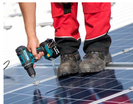
Die Module werden mit einer Universal-Modulklemme an den Schienen befestigt.
