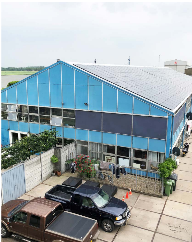
756 panneaux solaires au total couvrent les entrepôts, représentant une économie d'énergie de 20 à 25 pour cent.
