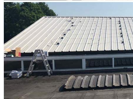
Un profilé du système ClickFit EVO pour toits en acier facile à monter (photo du haut). La photo du bas montre les rails du système faits sur mesure, sur lesquels l'installateur encliquette et fixe les panneaux solaires.
