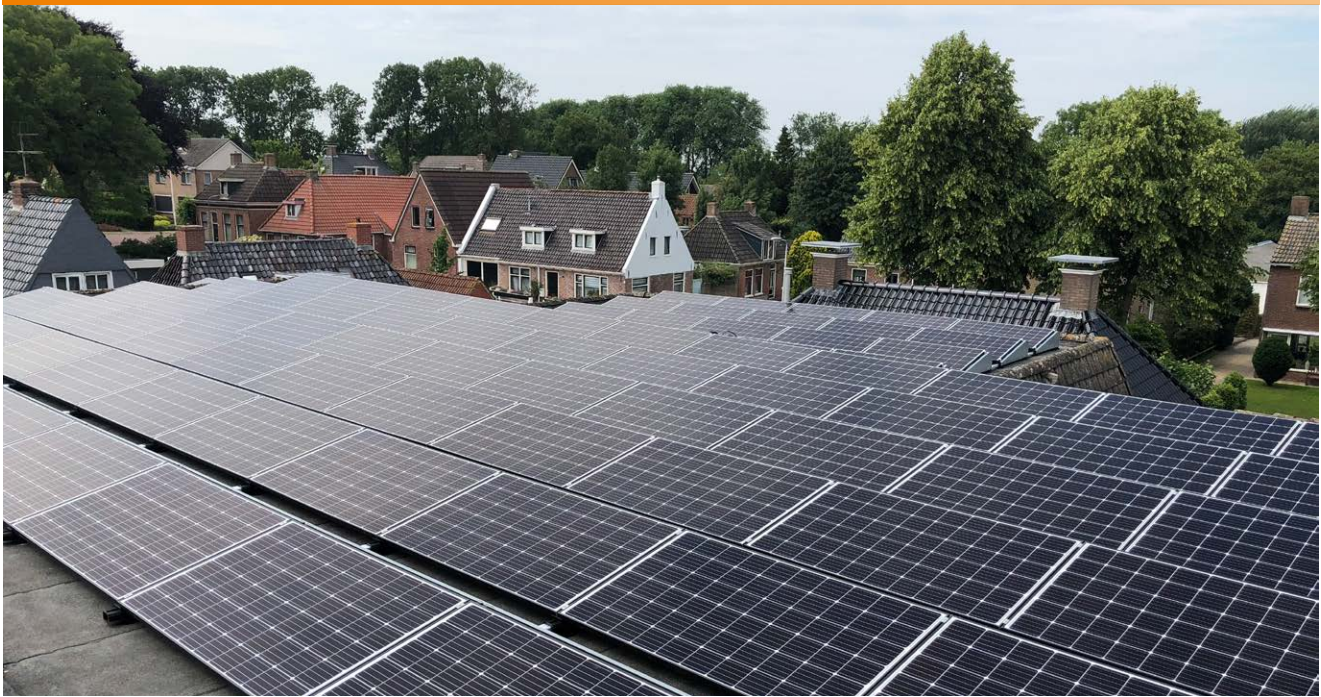
400 panneaux solaires au total sont installés sur deux toits plats avec le système de montage FlatFix Fusion.
