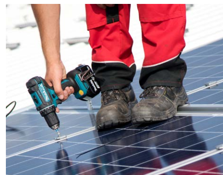
Les panneaux sont fixés sur les rails avec un module de serrage universel.
