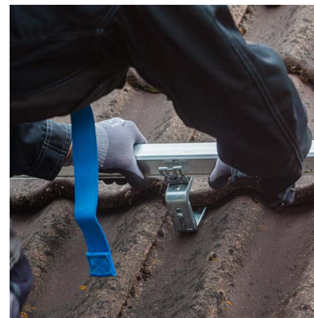
De traploos verstelbare dakhaken zijn universeel te gebruiken bij verschillende soorten dakpannen en diktes panlatten.
