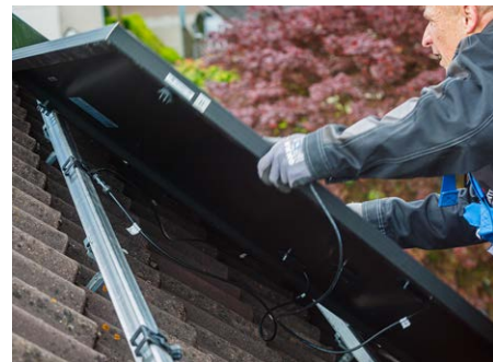
De zonnepanelen klikken moeiteloos op het mooi zwart afgewerkte ClickFit EVO-systeem met de handige montagehulpen.
