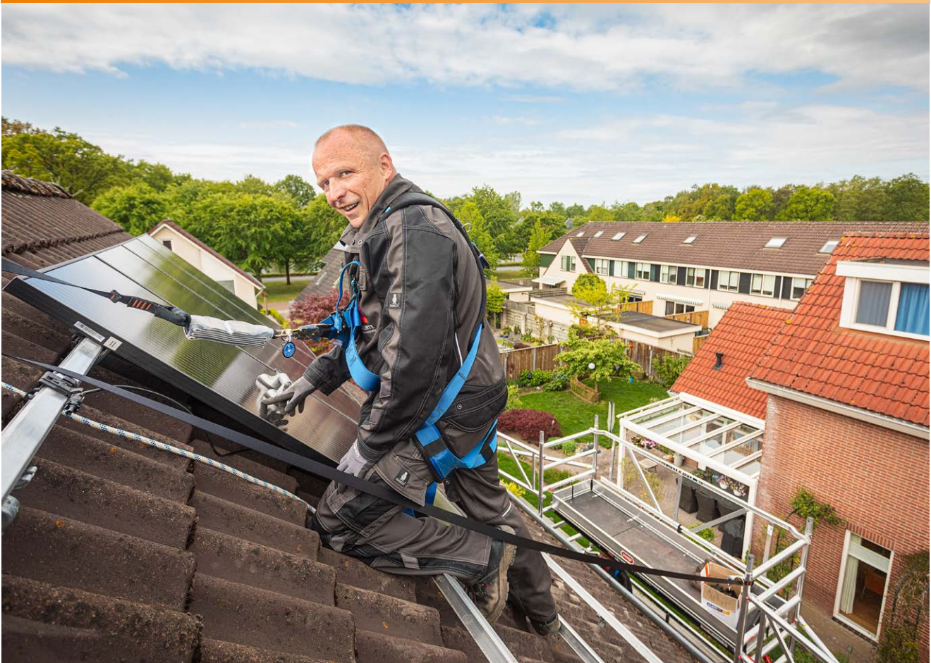
Het ClickFit EVO-systeem is sterk, licht en flexibel. Werk je volgens het bouwplan dan heb je 20 jaar garantie.
