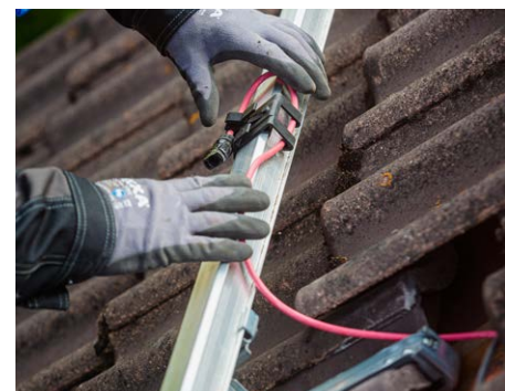
In de kabelclip bevestig je eenvoudig de stekker zodat deze niet nat kan regenen.
